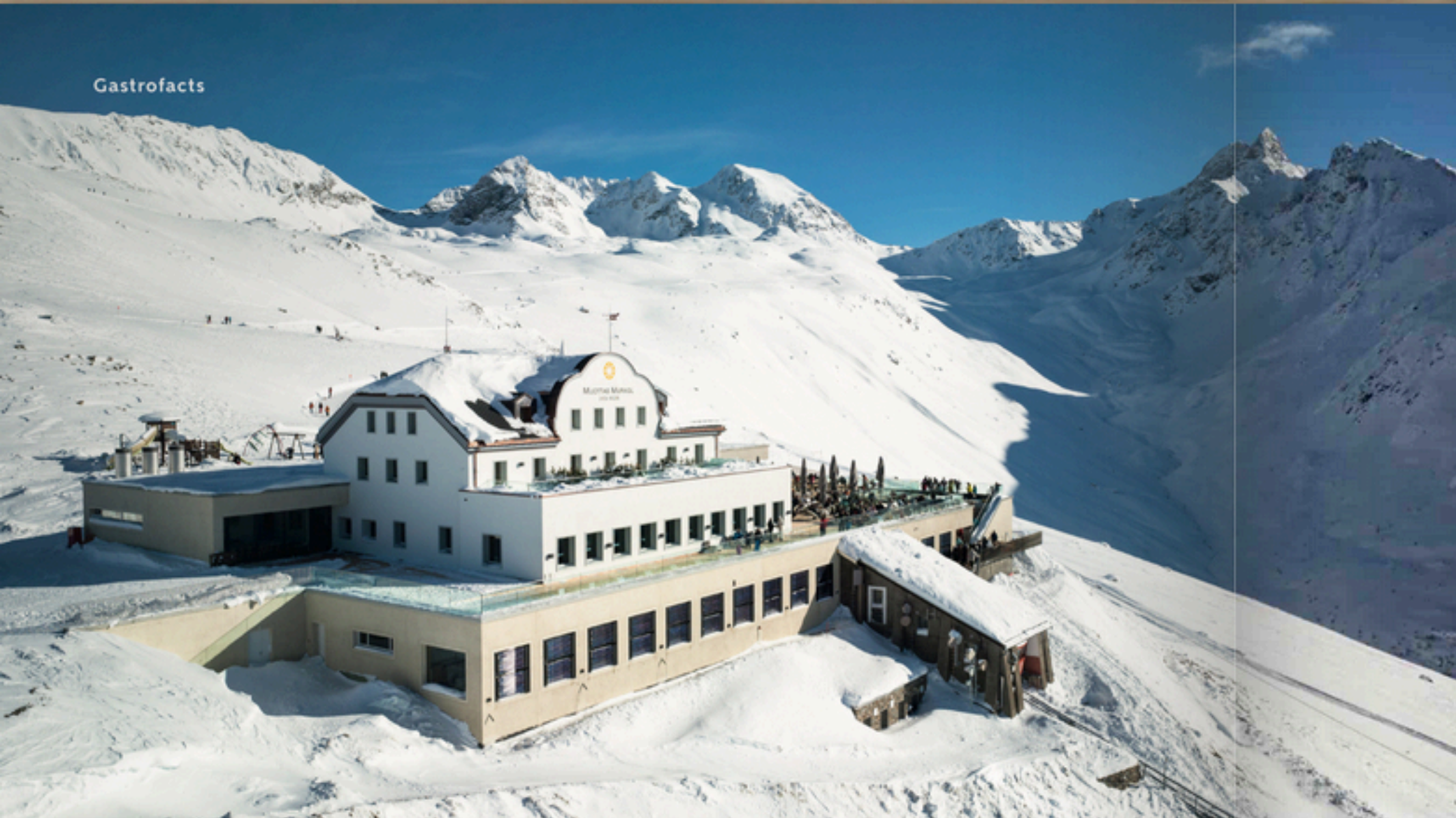
Romantik-Hotel Muottas Muragl: Die unterste Fensterreihe ist mit Röhrenkollektoren ausgerüstet und sorgt zusammen mit den Flachkollektoren auf dem Dach der Bahnstation für warmes Wasser.
